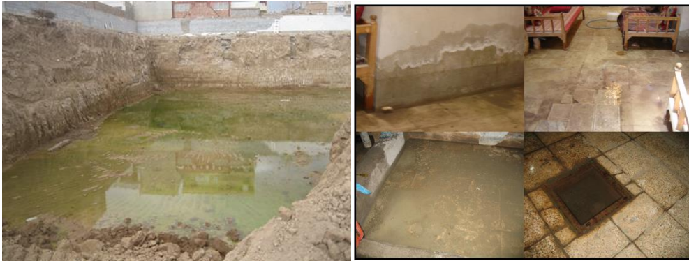
شکل ۱۶. بالا آمدن سطح آب چپ) در بخش های قدیم شهر (میدان مشتاقیه) راست) خیابان حافظ
