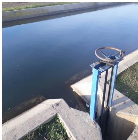
شکل (۳): دریچه کشویی قابل تنظیم جهت آبیاری از کانال اصلی
