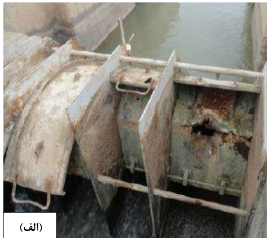
شکل (۶): مشکلات دریچه‌های شبکه آبیاری مغان، الف) پوسیدگی دریچه نیربیک ب) تخریب دریچه نیربیک
