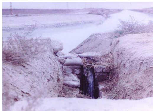
شکل (۷): تخریب کانال و آبیگری غیر اصولی (پریز)
