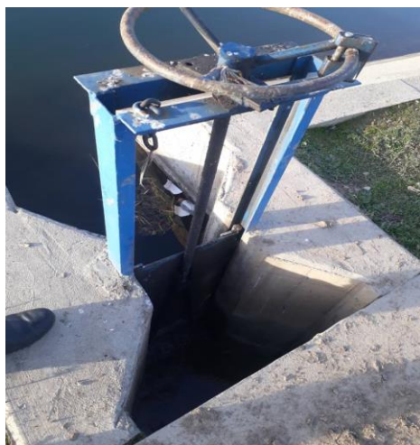
شکل (۳): دریچه کشویی قابل تنظیم جهت آبیاری از کانال اصلی
