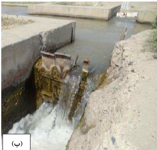
شکل (۶): مشکلات دریچه‌های شبکه آبیاری مغان، الف) پوسیدگی دریچه نیربیک ب) تخریب دریچه نیربیک
