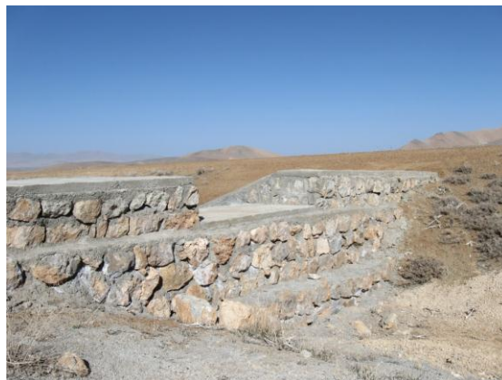
شکل (۲): نمایی از سازه احداث شده در منطقه
