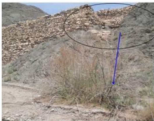
شکل ۶: کاهش تاج بند هلاکو به واسطه جلوآمدگی صخره و استفاده از آن به عنوان سرریز جهت عبور جریان‌های سیلابی
