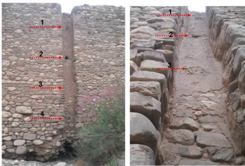
شکل ۸: نمای بالادست بند و دریچه‌های آبیگر بند هلاکو (۴ دریچه با شماره و فلش مشخص شده‌اند)
