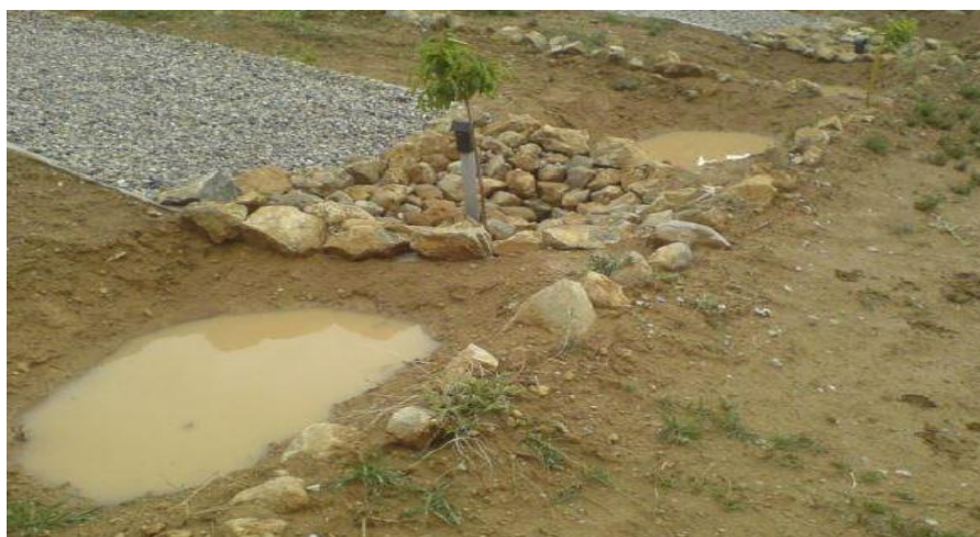
شکل (۵): احداث دیواره عایق در پایین دست چاله نهال با هدف کاهش سرعت جریان زیر سطحی
