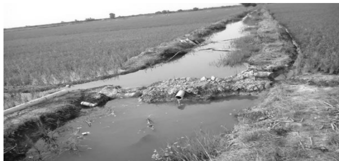
شکل ۱- ایجاد بند و آبگیری از زهکش در کرت‌های انتهایی، طرح تجهیز و نوسازی اسماعیل کلا، جویبار، مازندران
