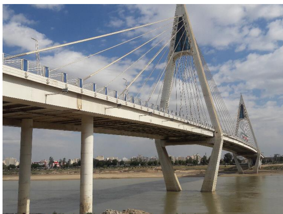
شکل (۱): نمایی از پل غدیر در اهواز با پایه‌های زاویه‌دار نسبت به جریان
